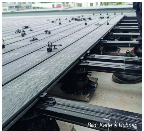
Abb. 22 Unsichtbare Befestigung der Dielen in den Fugen.
