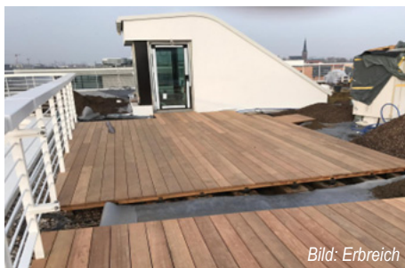
Abb. 23 Holz Unterkonstruktion mit Stellfüßen auf Kiesbett.
