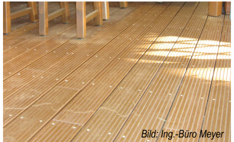
Abb. 21 Sichtbare Verschraubung der Dielen.
