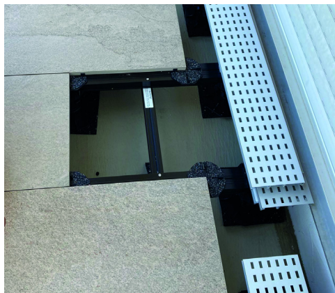
Abb. 25 Terrassenplatten mit Drainageprofil (links), Holzdielen mit Drainageprofil vor Terrassentür (rechts).
