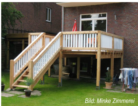
Abb. 14 Aufgeständerte Terrassen bieten Flächenerweiterungen auf ganz einfache Art. Aufwendige Erdanfüllungen können vermieden werden.
