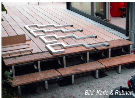
Abb. 9 Alu-Unterkonstruktion für eine Terrassentreppe.
