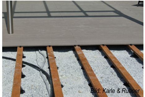
Abb. 18 Unterkonstruktion auf Kiesbett.
